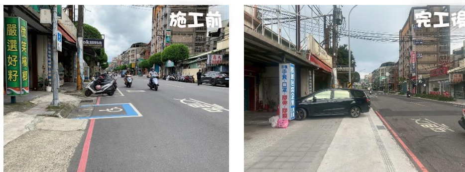
圖二十二：新北市土城區中央路1、2段人行道改善工程
