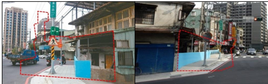
圖十二：裕民路及清水路岔口拓寬道路工程竣工照
