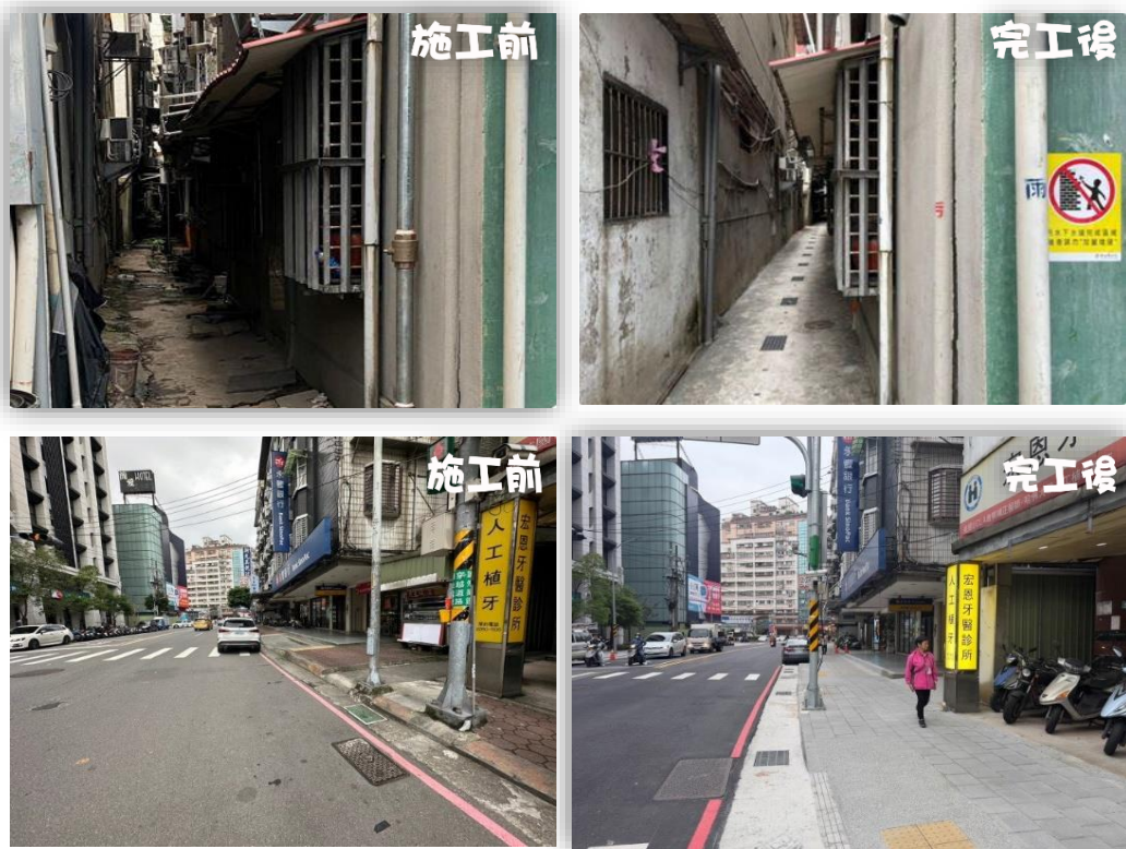
圖十五：污水下水道工程與中央路 1、2 段人行道改善工程
