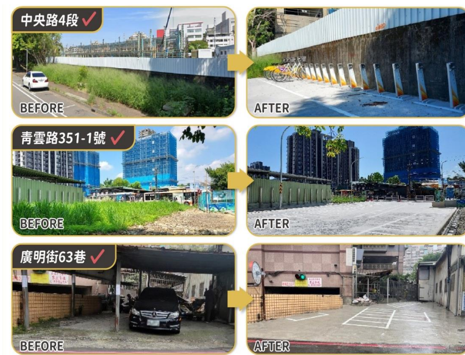
圖十五：新北市土城區國有地活化、新設機車格工程
