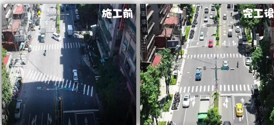
圖十四：新北市土城區路口行穿線改善工程(金城路三段人行道改善)
