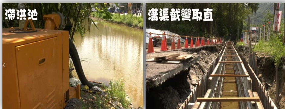
圖十七：新北市土城區和平路積水改善工程
