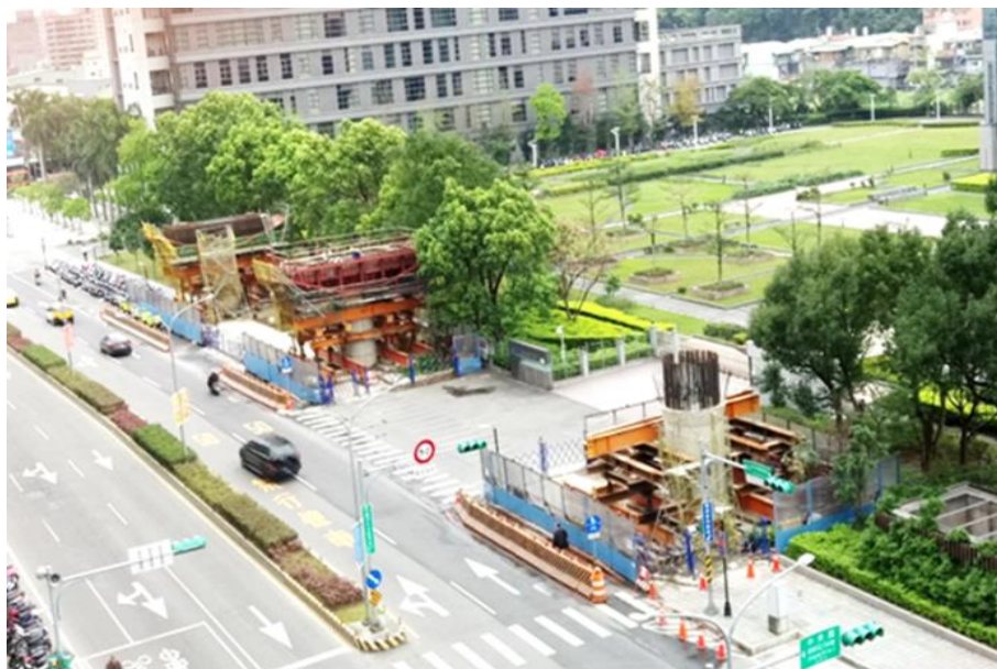
圖七：捷運三鶯線頂埔站施作現況
