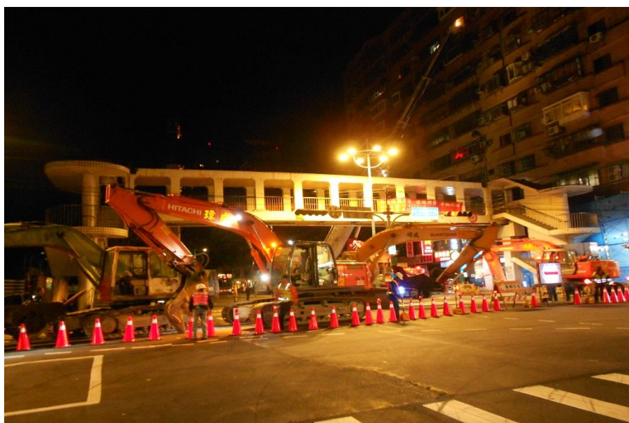
圖八：金城陸橋拆除工程
